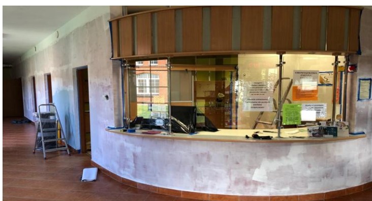
Fot. pływalnia, odświeżenie ścian w holu , hala OSiR
